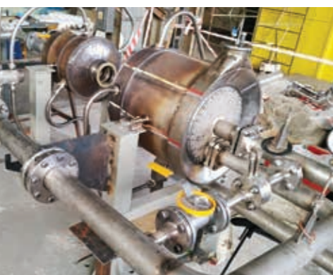
Рис. 3. Монтаж стенда рекуператоров
